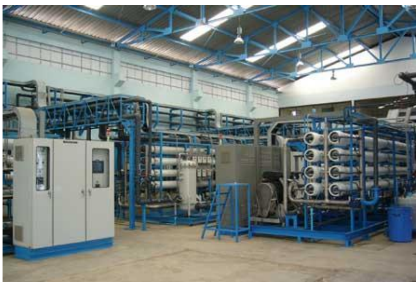
รูปที่ 2.3 ขั้นตอนของการผลิตน้ำประปา โดยระบบรีเวอร์ส ออสโมซิส (สำนักงานประปาอำเภอเกาะสมุย. 2552)
