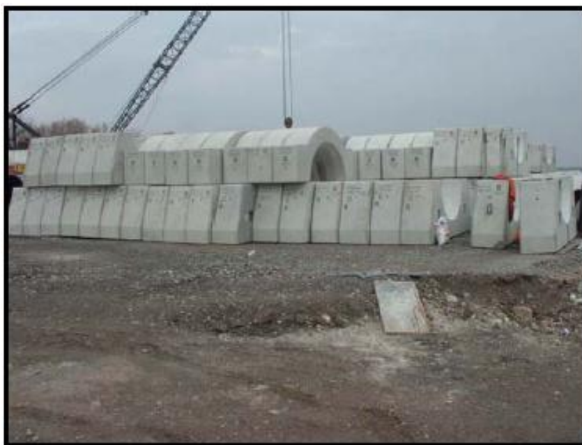
รูปที่ 2.6 ท่อนคอนกรีตขณะอยู่ที่หน้างานสามารถทำได้หลายรูปแบบ
