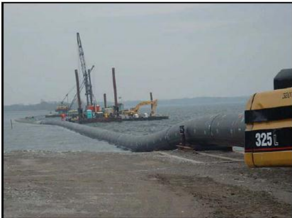
รูปที่ 2.8 ท่อที่ยังไม่ได้วางท่อน้ำหนัก กำลังถูกปล่อยไปยังเรือ Barge เพื่อทำการติดตั้งวางท่อน้ำหนัก
